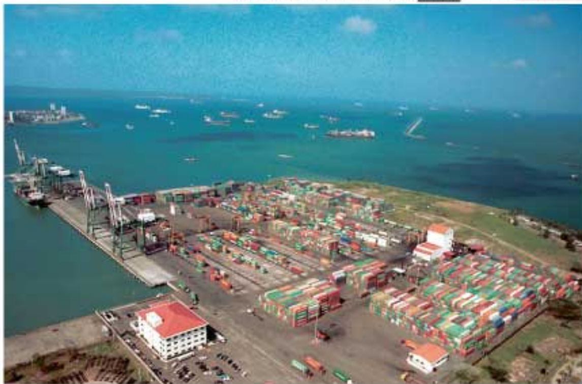
Puerto de Contenedores de Manzanillo.
